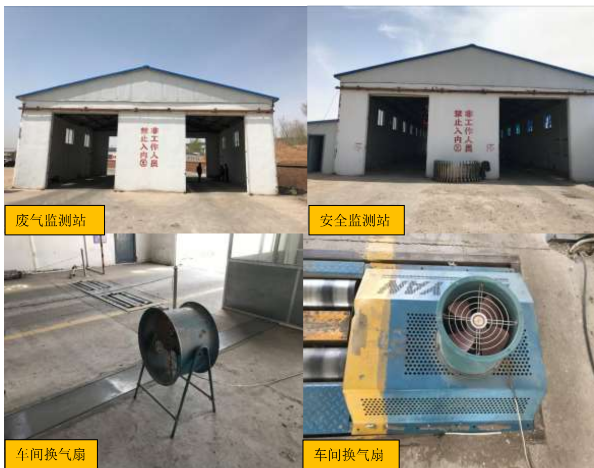
图 4.1-1 废气处理设施图
