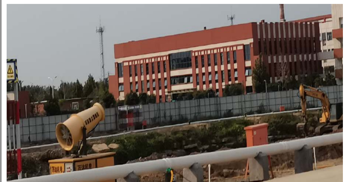
调查地块现场照片
