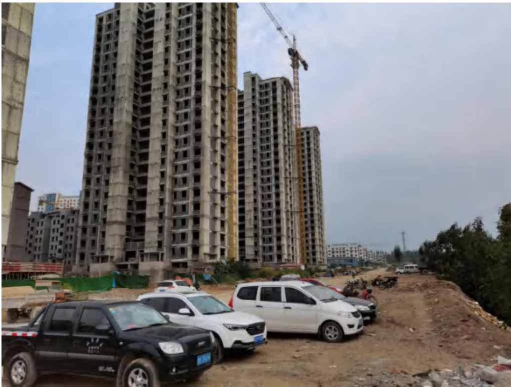
地块北侧在建小区
